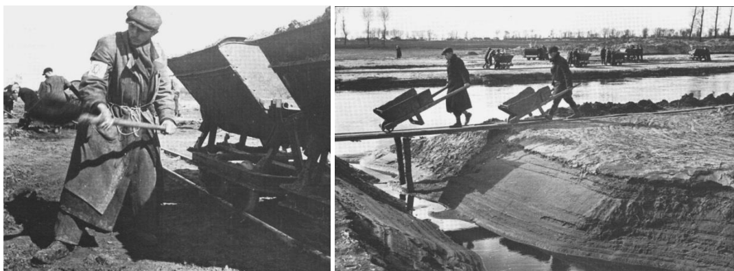
На земляных работах
