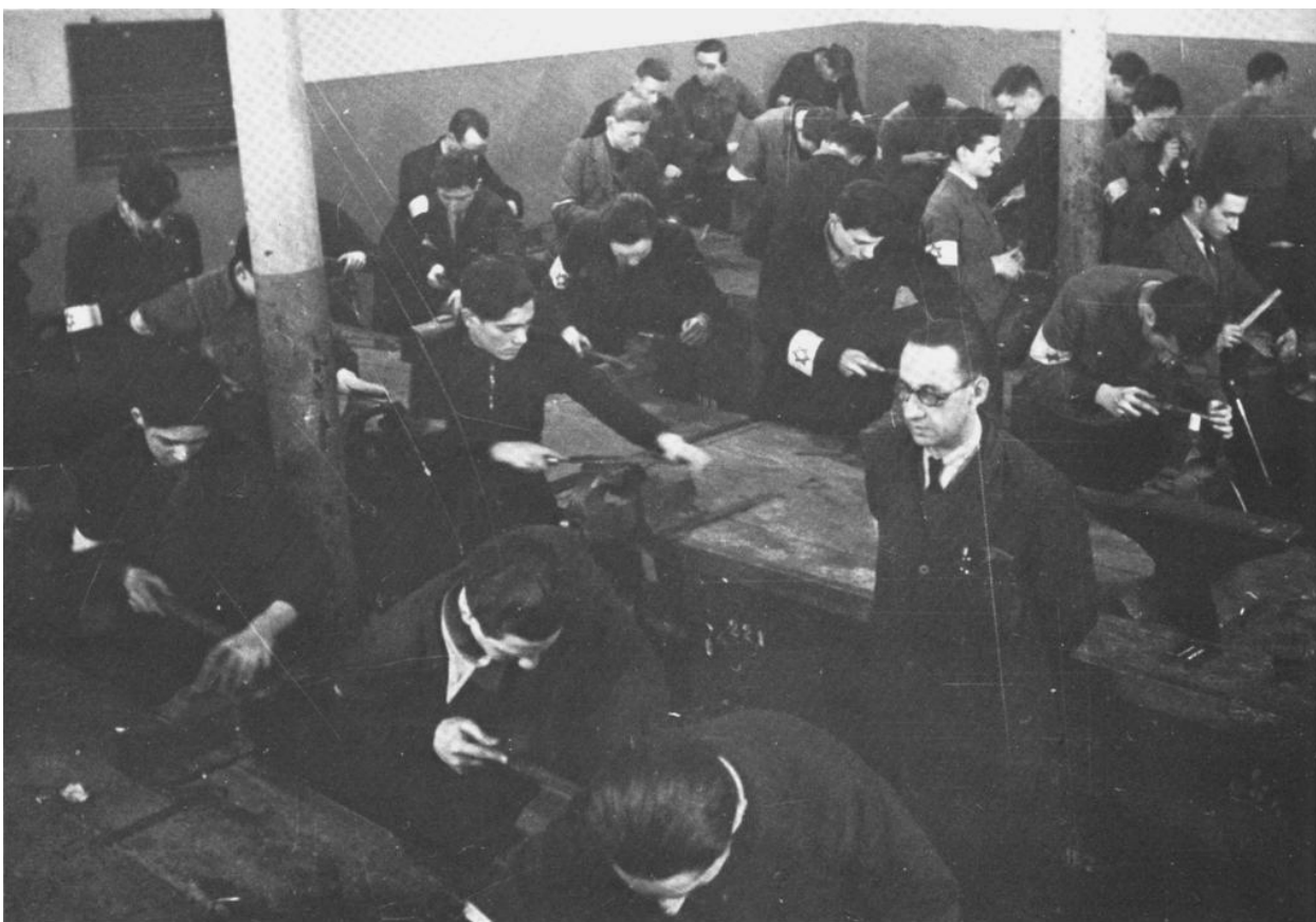
Слесарные работы на заводах Тоббенса
