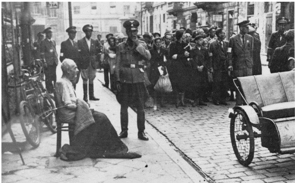
Колонна узников направляется в Трeблинку.
